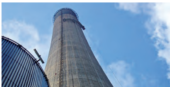
Auch Kamin- und Kühlturmsanierungen sind eine Spezialität des Bereichs Betoninstandsetzung
